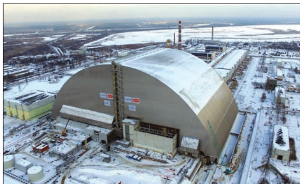
Арка — основна споруда нового безпечного конфайнменту
