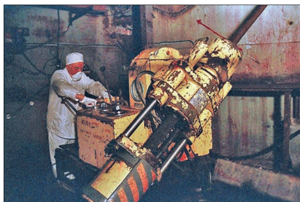
Наукові співробітники ІПБ АЕС виконують роботи в приміщеннях об'єкта «Укриття»
