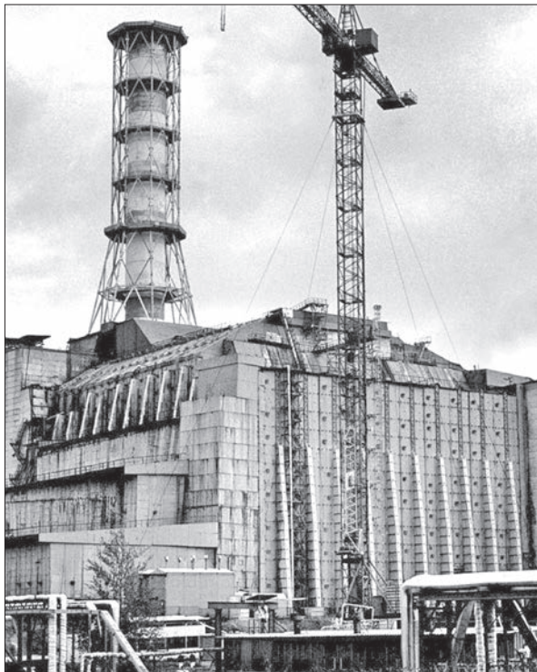
Законсервованій енергоблок № 4 Чорнобильської АЕС — об'єкт «Укриття»
