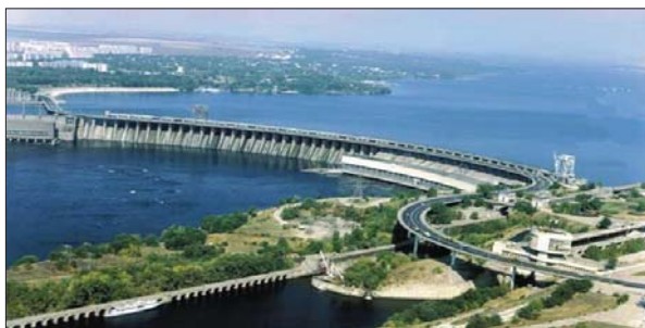
Рис. 3. Загальний вигляд автодорожнього проїзду через греблю ДніпроГЕС
