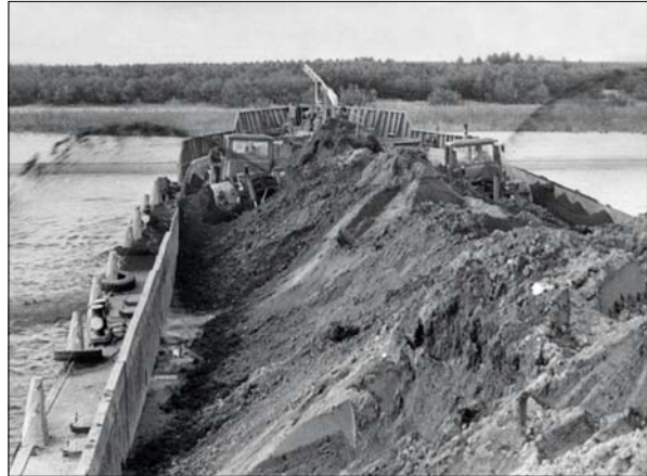
Рис. 3. Роботи з дезактивації р. Прип'ять комплексним адсорбентом на основі природного цеоліту, шлаків та інших складових
