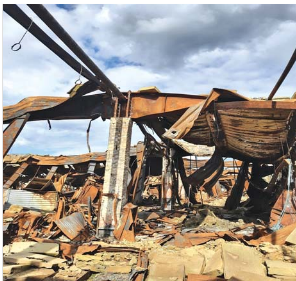
Рис. 11. Загальний вигляд знищеної будівлі гіпермаркету «Епіцентр» у м. Харків після бомбардування 25 травня 2024 р.
