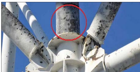
Рис. 4. Приклади пошкоджень окремих елементів конструкції київської телевежі: а — наскрізні отвори в елементах трубчастого восьмикутника; б — вирив розміром 200×40 мм на елементі барабана; в — вм'ятини діаметром 30 мм і завглибшки 12—15 мм
