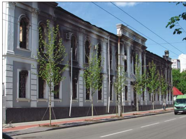
Фото 9. Будинок окружного суду в Чернігові, постраждалий від ракетного обстрілу 25 лютого 2022 р.
