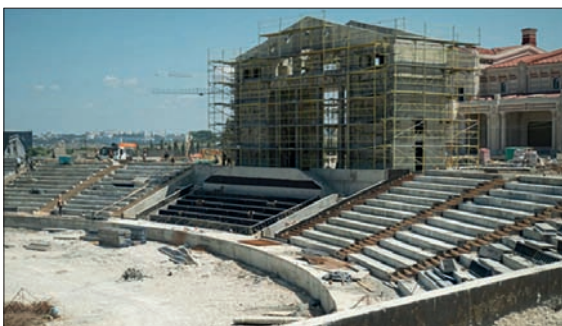
Лл. 2. Будівництво амфітеатру на території Херсонеса
