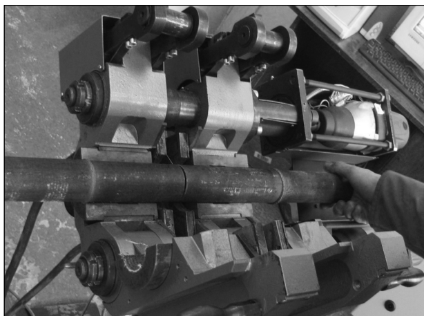
Рис. 3. Установка труб у затискні пристрої зварювальної машини
